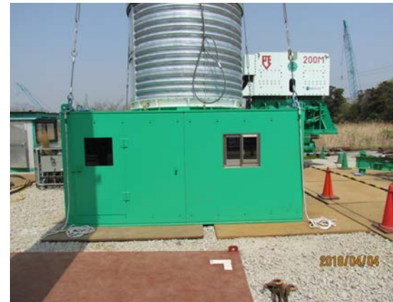
下部防音室の外観
