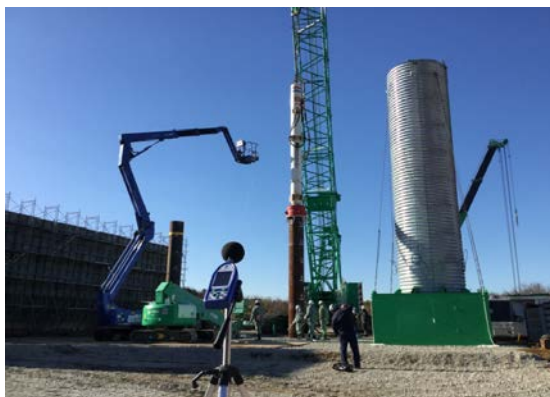
鋼管杭打設(装置無し:計測状況)
