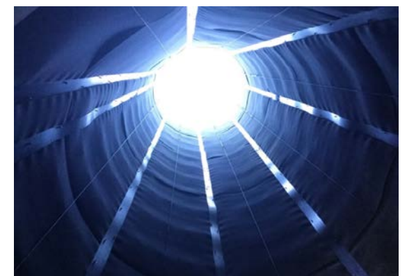
上部防音室の内部
