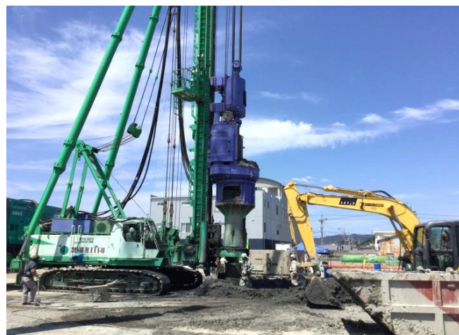
② 中掘り回転圧入完了
