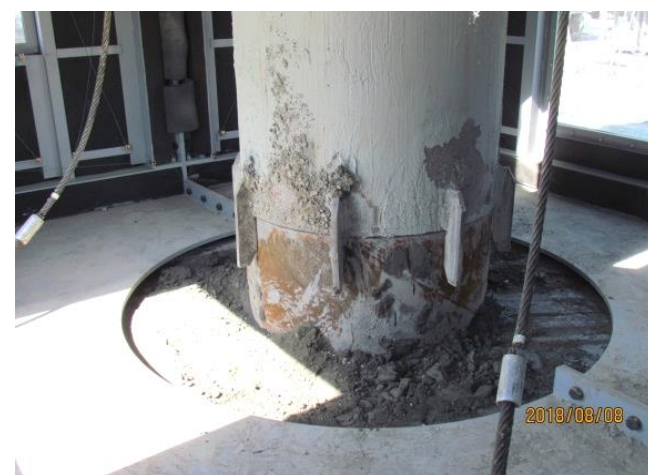
⑧ ヤットコ設置完了(装置内)
