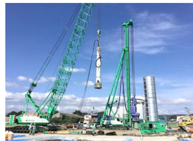
⑨ 油圧ハンマ設置
