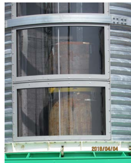
装置の設置(上部防音室内部)
