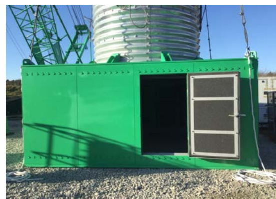
下部防音室の外観
