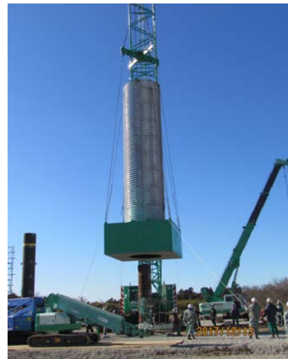
装置の設置状況
