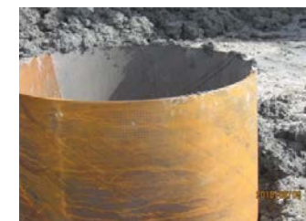
⑤ 油圧パイプロハンマ打設完了
