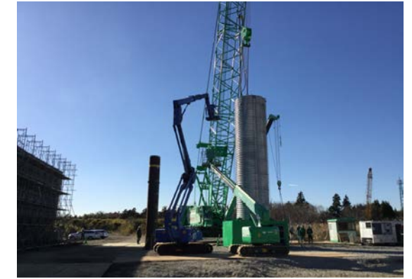
鋼管杭打設(装置有り:計測状況)
