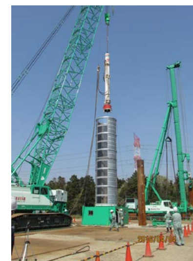
油圧ハンマ吊り込み(装置内)
