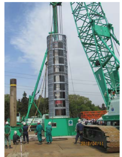
鋼管杭打設(装置有り:計測状況)
