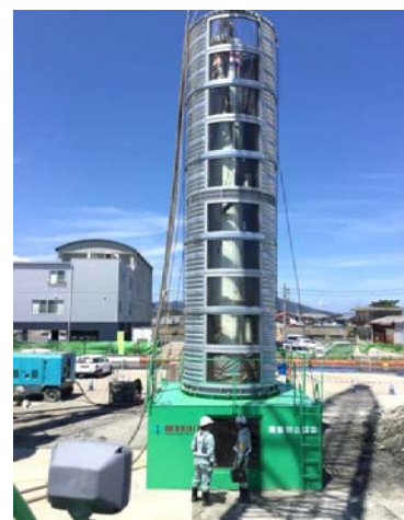
⑪ 油圧ハンマ打設完了
