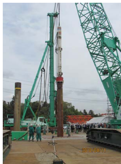
鋼管杭打設(装置無し:計測状況)
