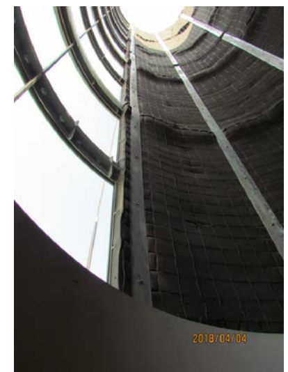
上部防音室の内部
