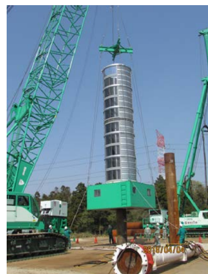
装置の設置状況
